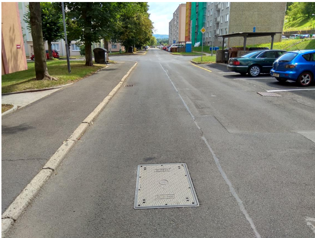
Detail poklopu teplovodu:
