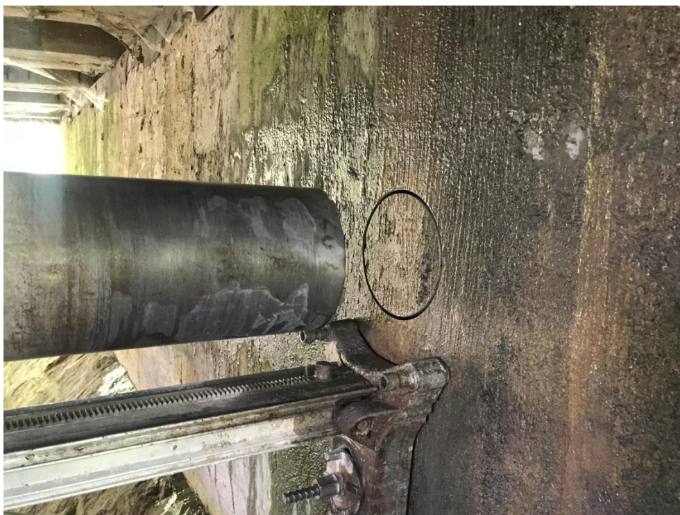
Obr.7 – Vrt V5, po odvrtání
