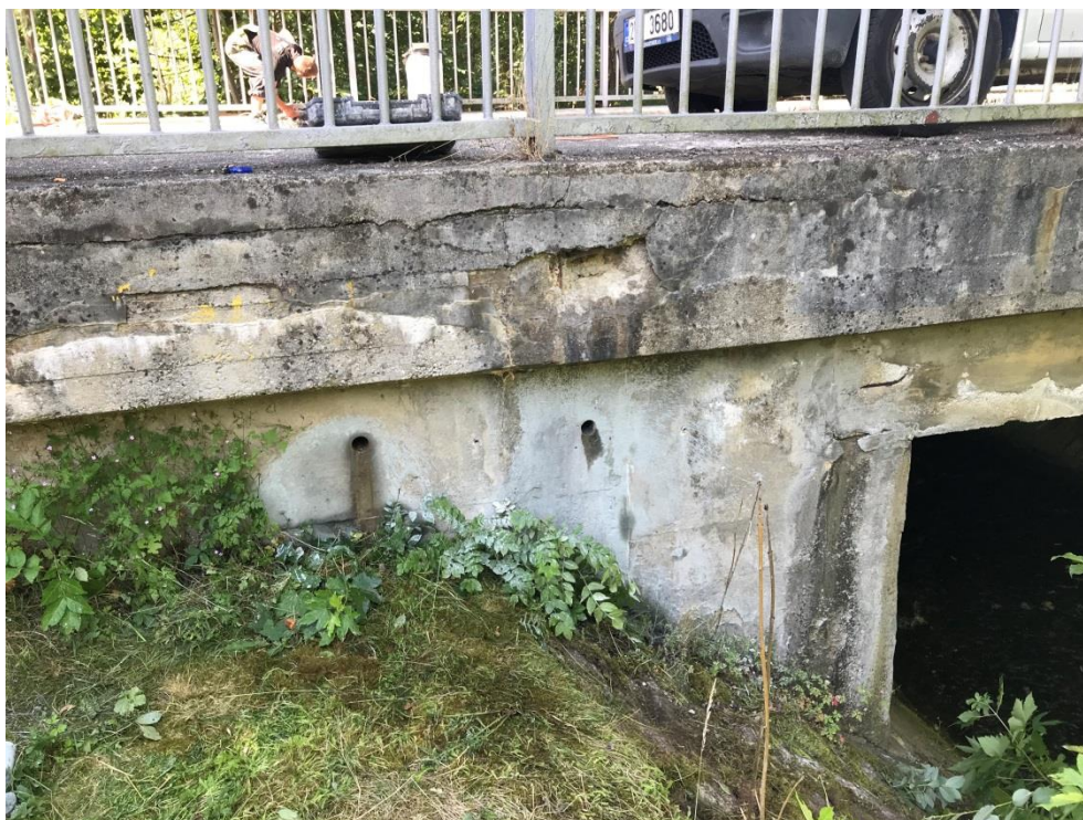
Obr.1 – Situování vrtů V1 a V2 na návodní straně.
