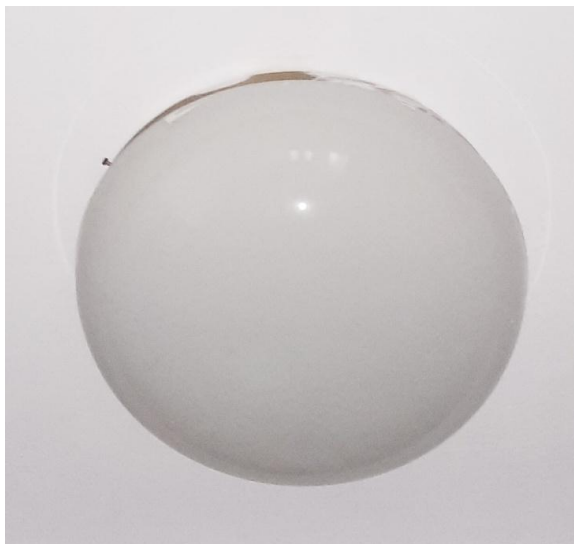
TK2- původní svítidlo č.6 Replika původního skleněného přisazeného svítidla Těleso – kov Kryt- mléčné sklo 4ks
