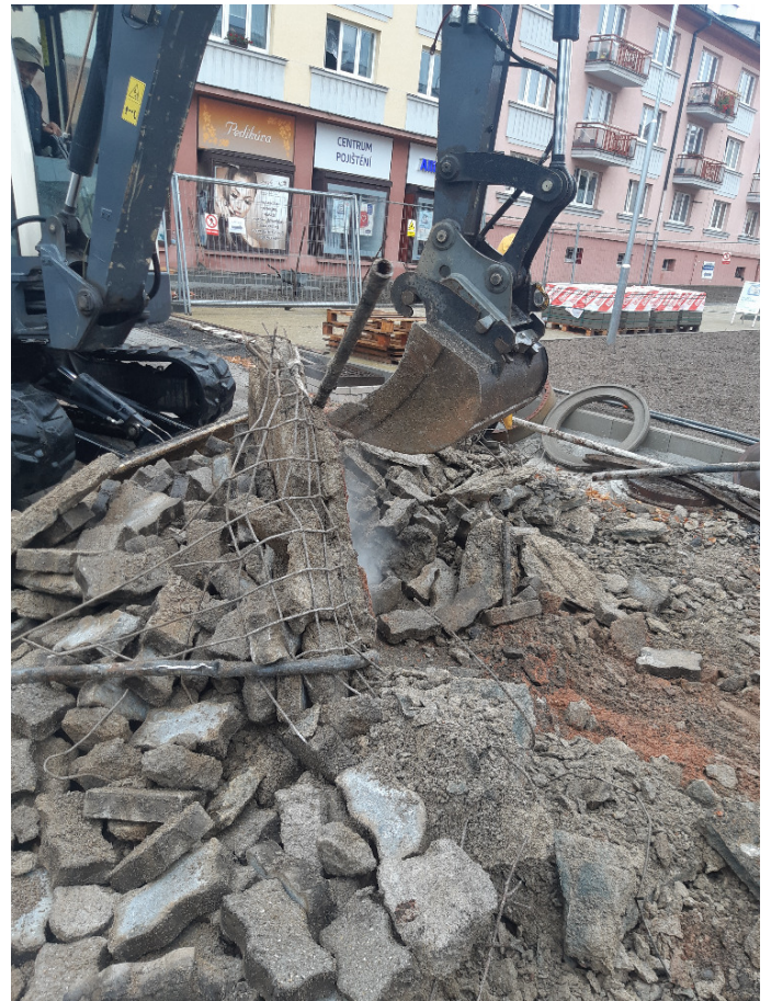
Bourání stávajících základů z železobetonu
