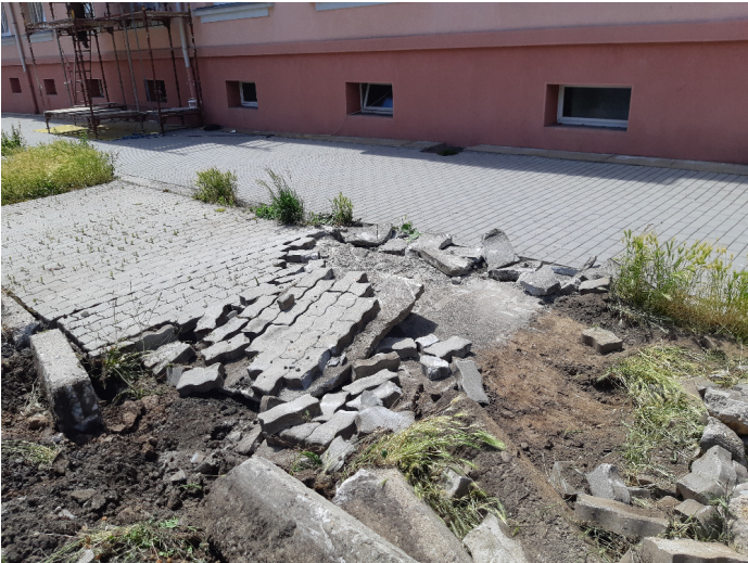
Bourání stávajících základů z prostého betonu pod stánky
