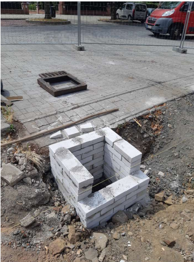
Oprava stávajících šachet UV
