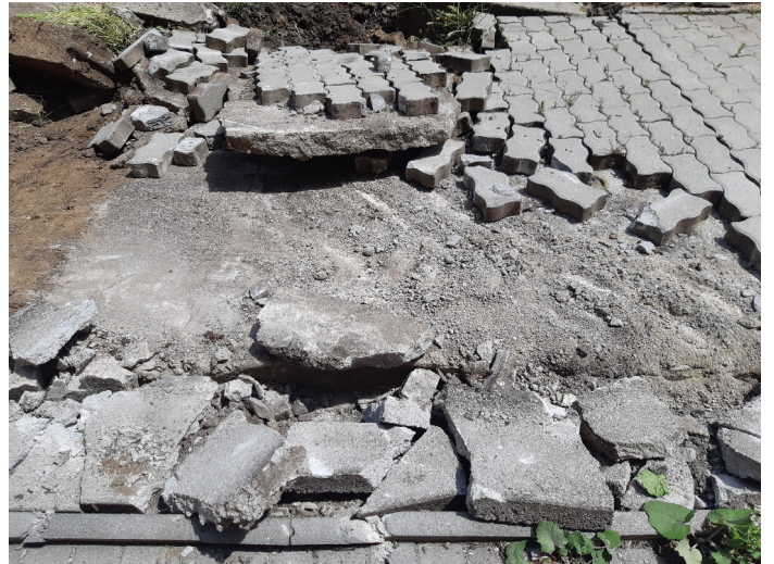
Bourání stávajících základů z prostého betonu pod stánky
