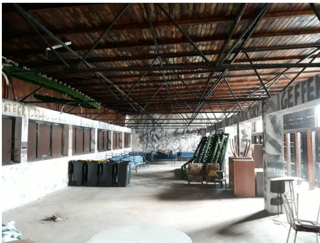
Obr.12: Celkový pohled do objektu skladu – příhradové zastřešení.
