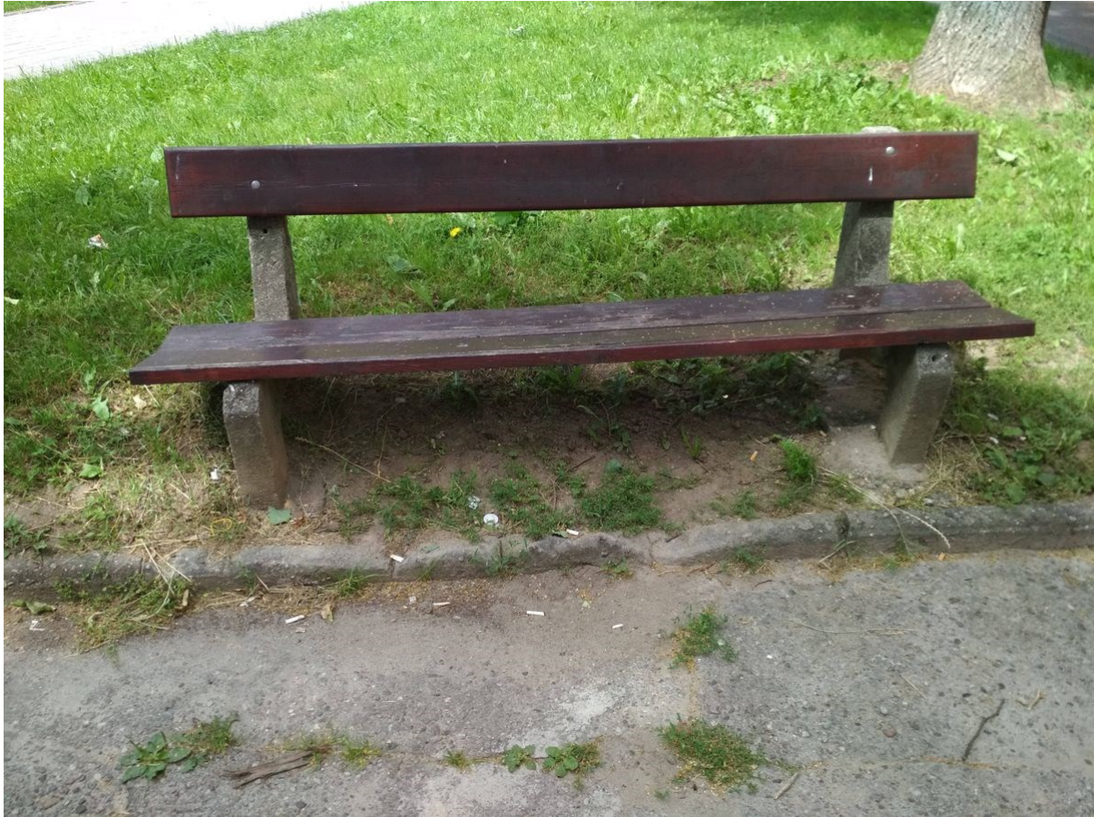
11. lavička s opěradlem- betonové nohy, 3 fošny
