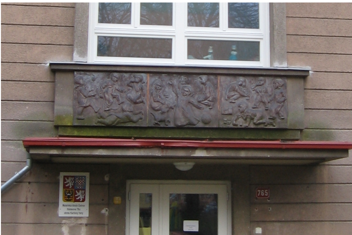
ozdobný prvek "děti" umístěný na parapetu na schodišti nad hlavním vchodem a jeho biologické znečištění
