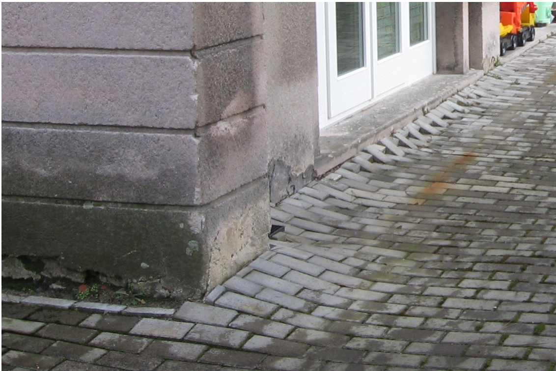
biologické znečištění a defekty v omítce u terénu (severní průčelí)
