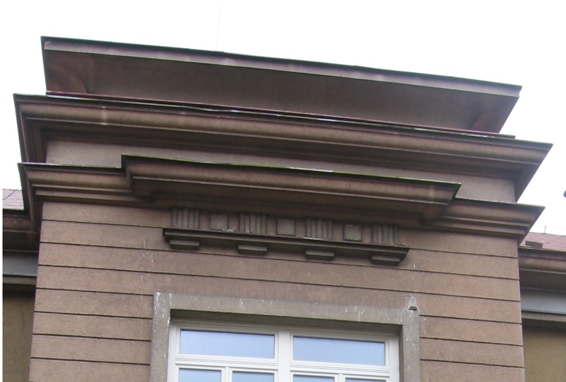
znečištění fasády od holubů, zkorodovaná oplechování říms, znečištění říms
