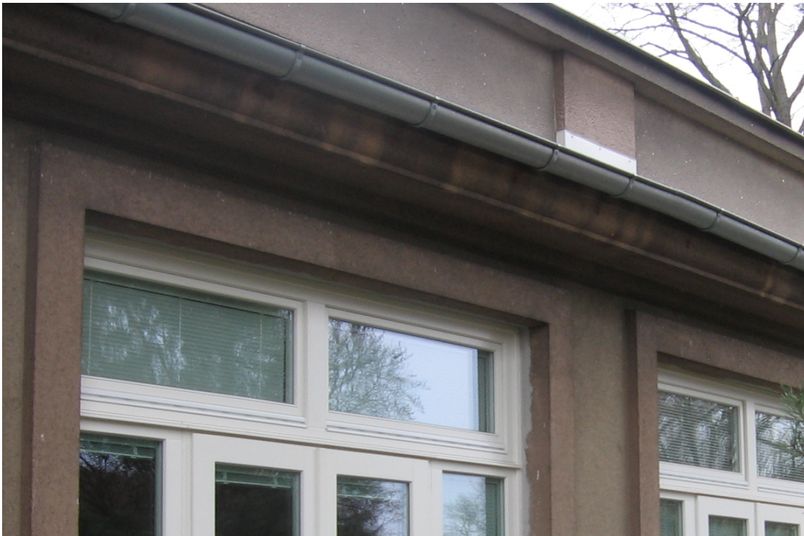
plošné znečištění říms
