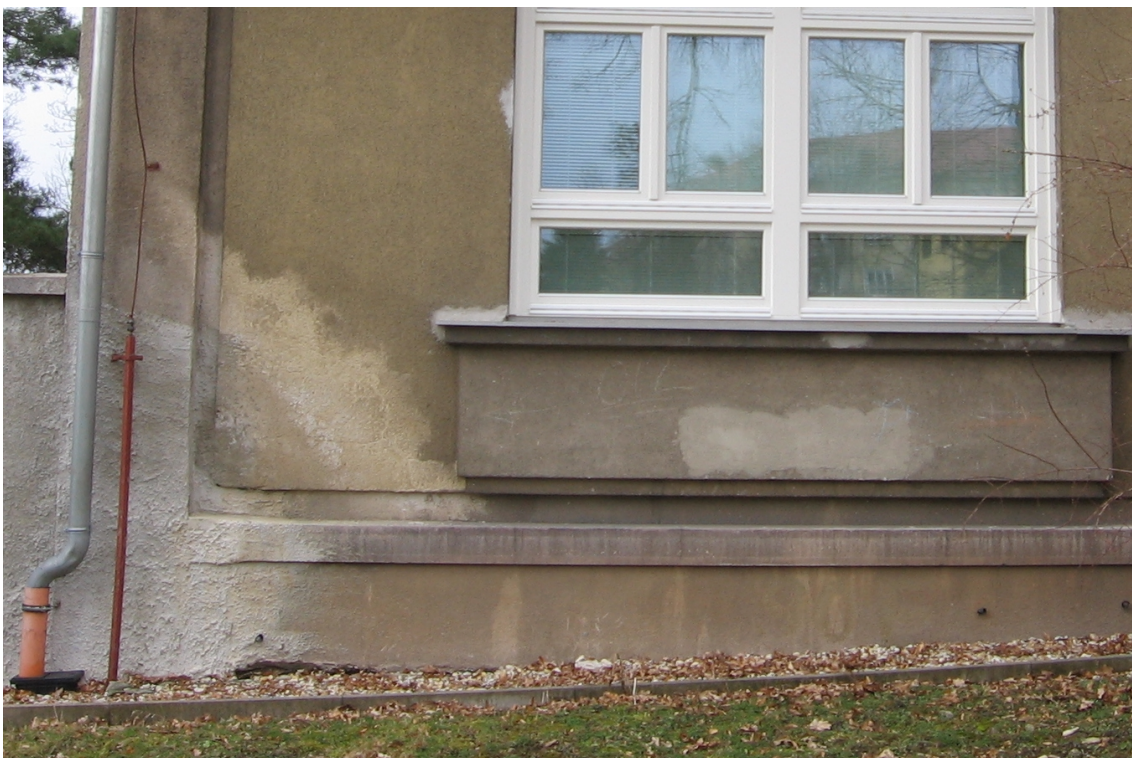
mapy s výkvěty od dříve zatékající vlhkosti nevzhledně provedené dřívější popravu na fasádě,
