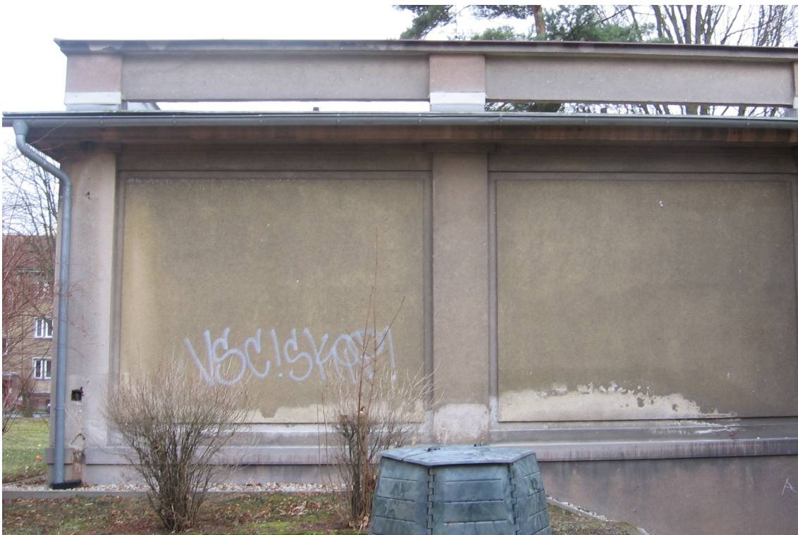
mapy a výkvěty po dřívějším zatékání, lokální poškození omítky
