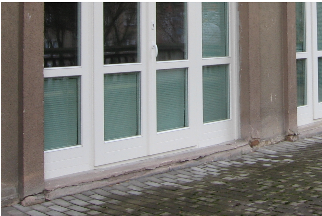
poškození schodu z 1. NP na terasu a poškození omítky vlhkostí ve styku s podlahou terasy
