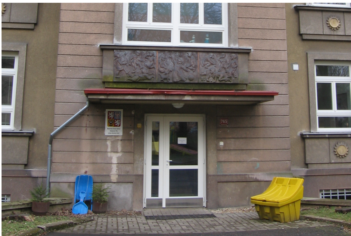
biologické znečištění fasády a ozdobného prvku, poškození plechového žlabu, lokální neodborné opravy omítky
