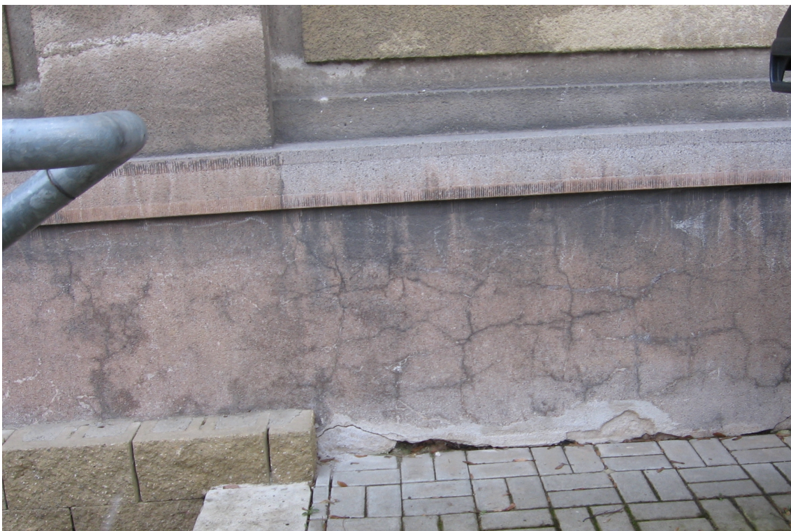
celoplošně popraskaná část soklu, mapy s výkvěty po dřívějším zatékání
